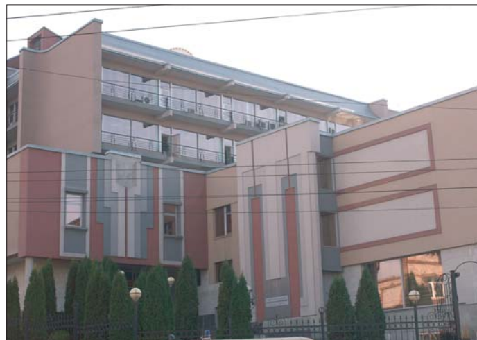
Вычислительный центр ЦБ
