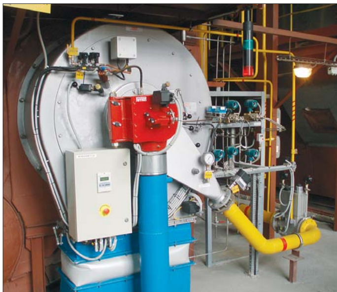
ФГУП «Гознак», СПб., 2006–2008 г. Котельная бумажной фабрики: замена существующей горелки ГМП-16 на горелку PETRO типа PP18G/PB18, замена на двух паровых котлах ДЕ-25-14-250ГМ существующей автоматики на АСУ ТП NORDVISION
