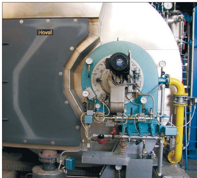
Пример установки ротационной горелки RAY на жаротрубном котле.
