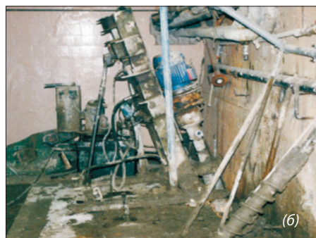
Фото 3. Общий вид инъекционных работ по усилению фундамента и основания с наружи (а) и внутри здания (б)
