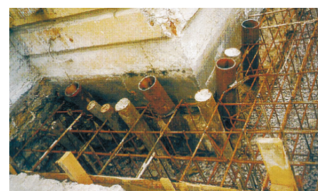
Фото 6. Усиление фундамента портика здания цементацией основания и буроинъекционными сваями (Музей истории Санкт-Петербурга)
