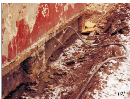
Фото 3. Общий вид инъекционных работ по усилению фундамента и основания с наружи (а) и внутри здания (б)
