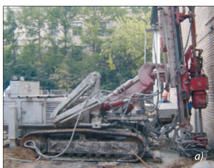
Рис. 6. Схемы усиления фундаментов буроинъекционными сваями: а) усиление ленточных фундаментов здания; б) усиление отдельно стоящего фундамента
