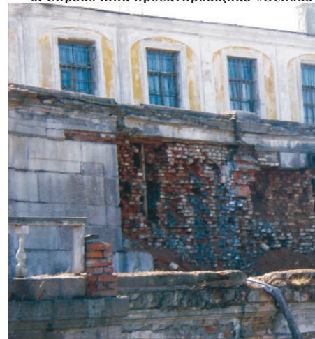
Фото 7. Усиление подпорных стен сваями Franki (дворец А. Меншикова, г. Ораниенбаум)
