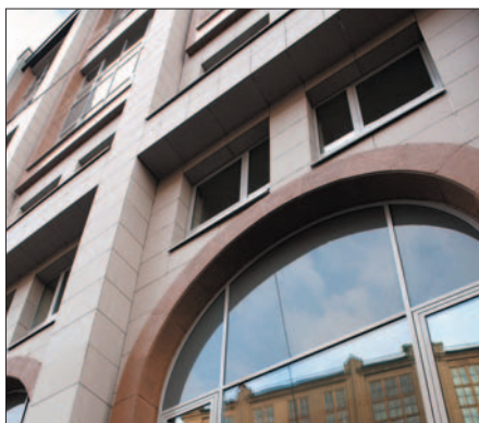
«Центральный телеграф» в Москве. Лицевая часть с фасадной системой «ОЛМА»
