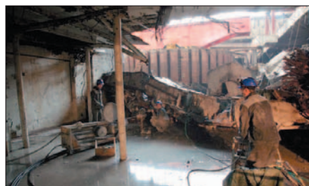
Подготовка к резке канатным автоматом CSA-1010 — охват бетонной глыбы канатной петлей
