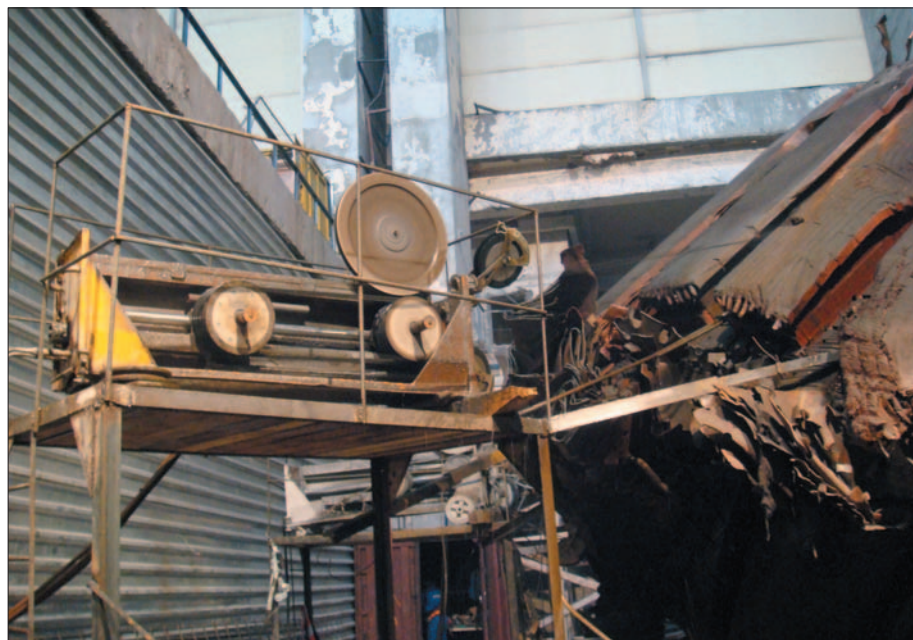
Канатные автоматы CEDIMA CSA-1001 в работе (вид сбоку)
