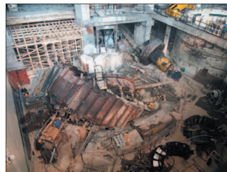
Гидроагрегат №2 (вид сверху): работают канатные автоматы
