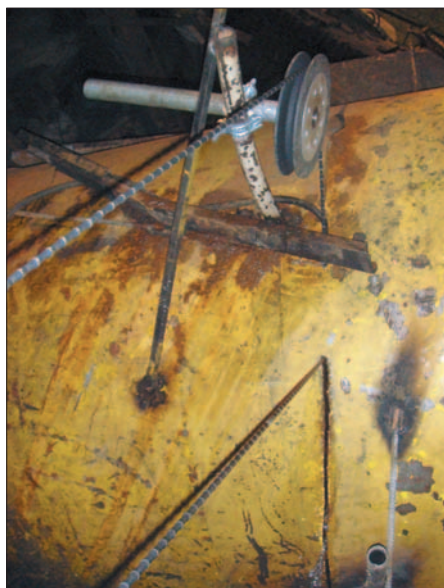
Резка металлических элементов с помощью специального алмазного каната по металлу и канатного накопителя
