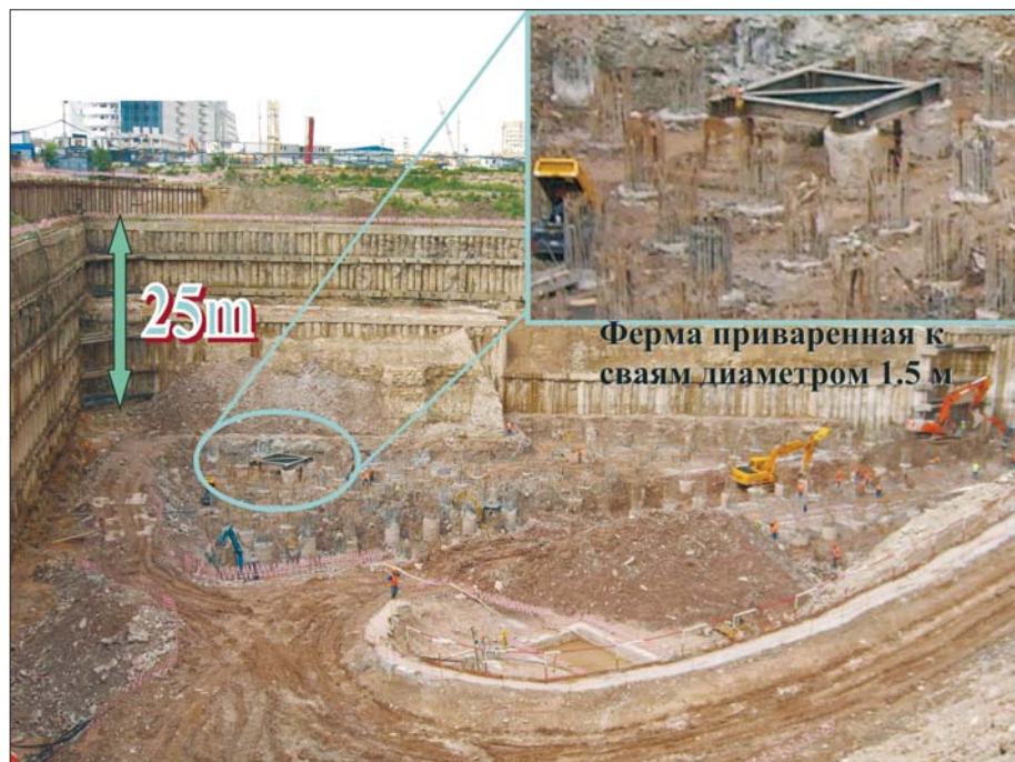
Испытания воскресенских глин штампами в котловане
