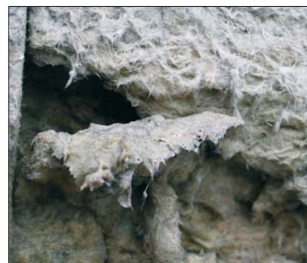
Состояние минеральной ваты без ветрозащитной мембраны
