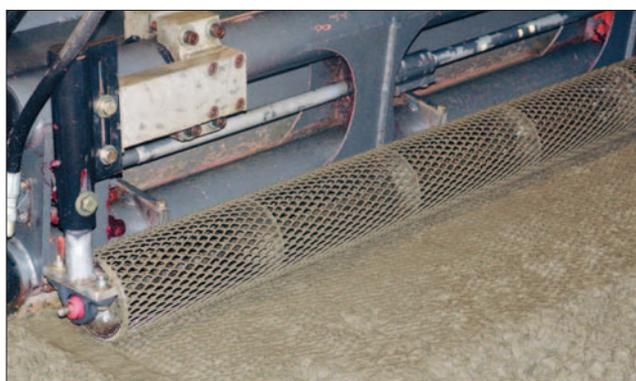
Укладка бетона при помощи оборудования LaserScreed
