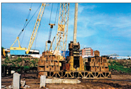
Фото 1. Сваевдавливательная установка на площадке
