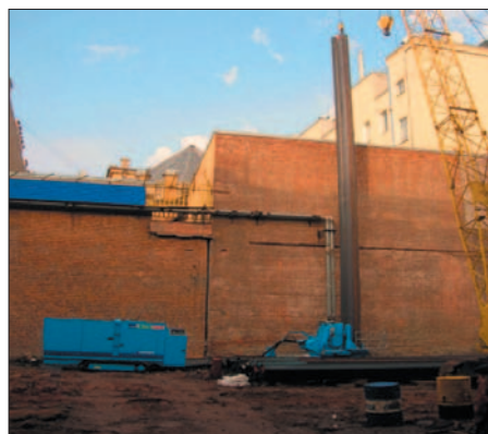
Фото 7, 8. Свайевдавливающая установка GV-ECO700S: погружение шпунта вблизи существующей стены
