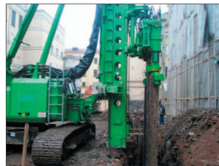
Фото 6. Установка BANUT 655 на площадке строительства бизнес-центра: вдавливание шпунтовых свай (Невский пр., 55)
