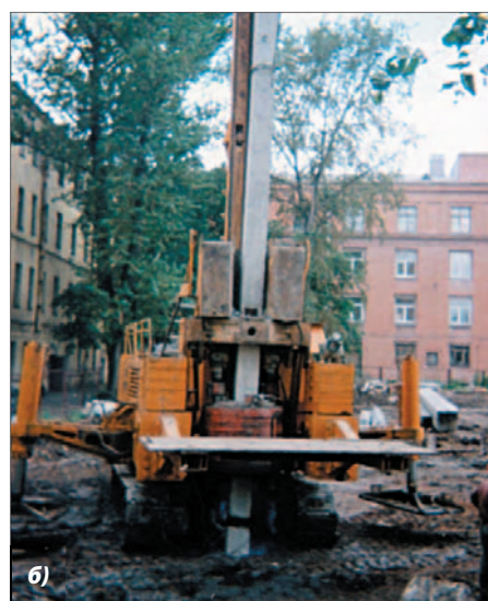
Фото 5. Предварительное рыхление грунта шнеком (а) и вдавливание свай установкой УСВ 120М (б) (ул. Шпалерная, 50, СПб)
