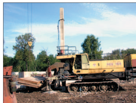
Фото 2. Установка УСВ-160М (статическое вдавливание свай)
