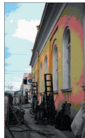
Фото 9. Работы по усилению старого фундамента наклонными буронагнеточными сваями (Таврический дворец, СПб)
