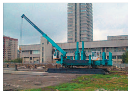
Фото 3. Установка для вдавливания свай на площадке строительства (Приморский район СПб)
