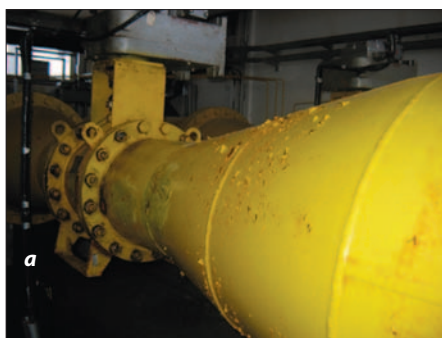
Антикоррозионная защита газопровода на Дзержинской ТЭЦ: а – до применения технологии «Абрис®», б – после применения технологии «Абрис®»
