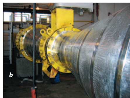
Антикоррозионная защита газопровода на Дзержинской ТЭЦ: а – до применения технологии «Абрис®», б – после применения технологии «Абрис®»
