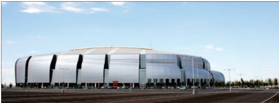
Стадион Ballpark — пример современного «интеллектуального» стадиона с безопасным функционированием
