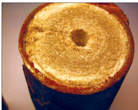
Рис. 1. Отложение солей в котловой трубе
