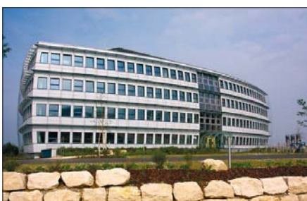
Фото 4. Пример офисного здания
