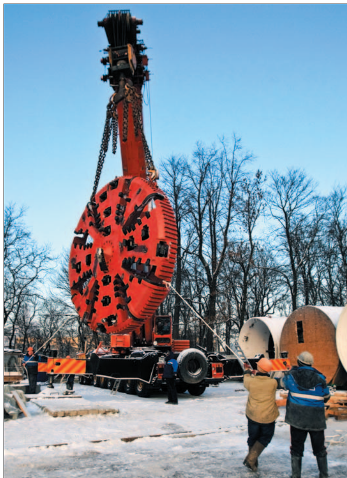
Спуск горнопроходческого комплекса Herrenknecht
