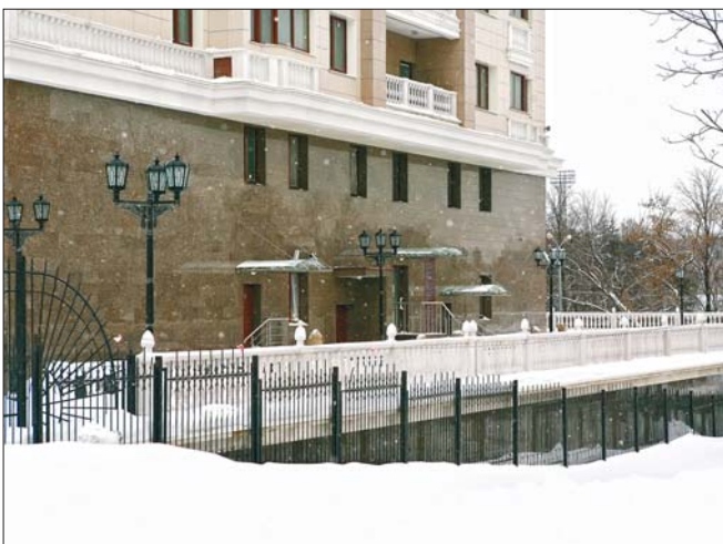
Фото 11. Оформление дворовой территории здания: ограждения из натурального гранита по проекту «Ронсон», карнизы из полимербетона на системе «Ронсон-100»
