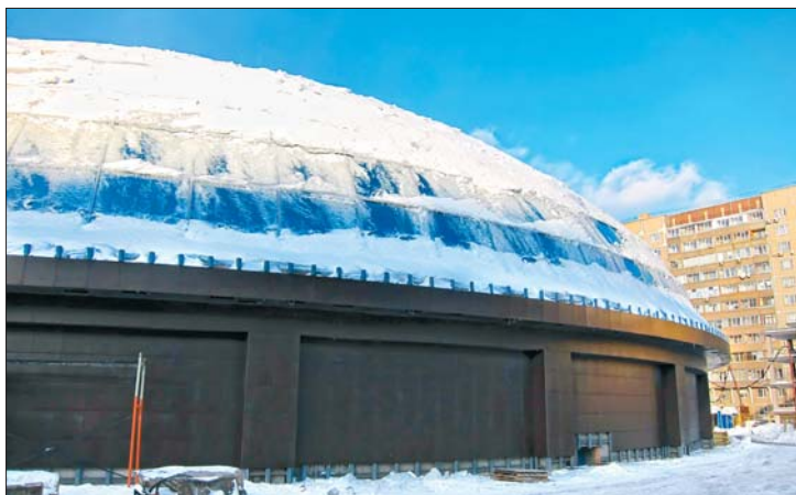
Фото 13. Устройство криволинейных участков фасада на системе «Ронсон-300» для плит из керамического гранита с видимым креплением и использованием профилей, гнутых по радиусу фасада
