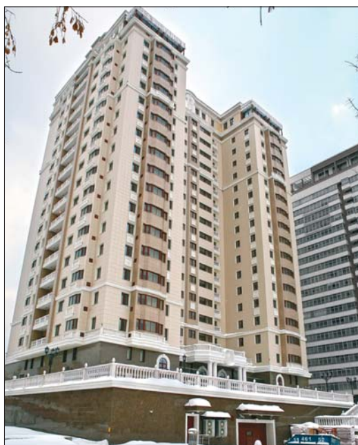
Фото 8. «Фамильный дом» (ул. Фотиевой): облицовка из натурального гранита, плит из керамического гранита, декоративных карнизов из полимербетона и ограждающих конструкций из натурального гранита по проекту «Ронсон»
