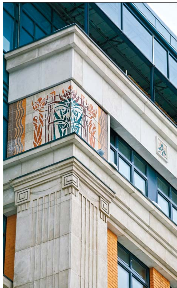
Фото 4. Система «Ронсон-400» с декоративными панно из керамического гранита и система «Ронсон-100» с карнизами и вертикальными колоннами из полимербетона в сочетании с декоративной кирпичной кладкой
