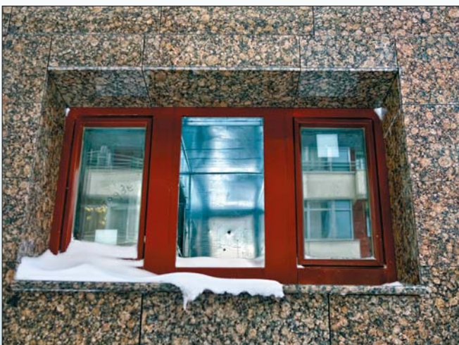
Фото 12. Оформление оконных обрамлений из натурального гранита на системе «Ронсон-400» с устройством внутренних противопожарных отсеков
