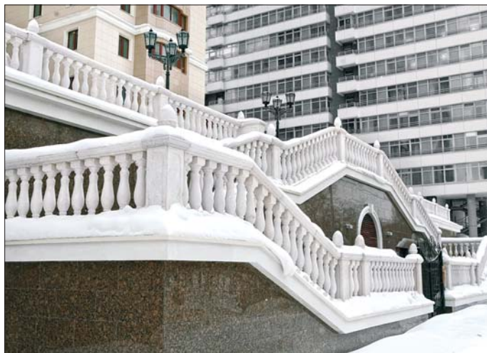
Фото 9. Оформление парадной лестницы: натуральный гранит на системе «Ронсон-400», витражные обрамления и декоративные карнизы из полимербетона на системе «Ронсон-100», перильные ограждения из натурального гранита по проекту компании «Ронсон»
