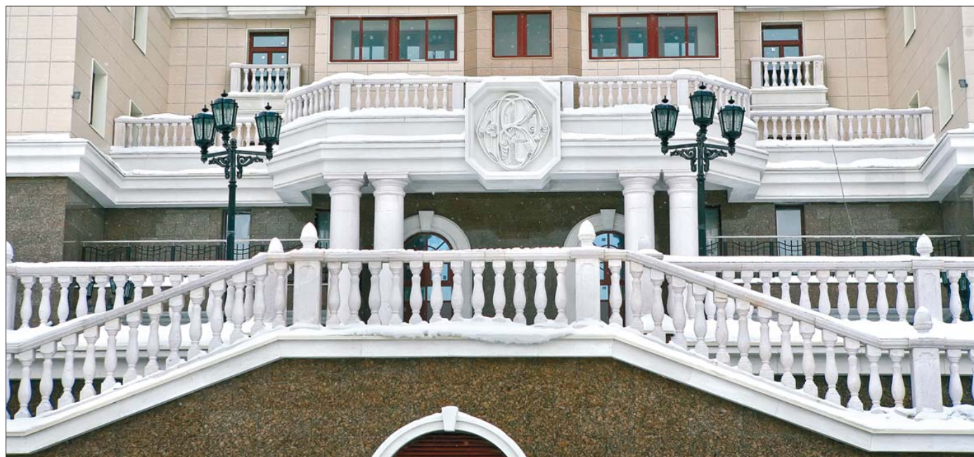
Фото 6. Оформление центрального входа: облицовка и ограждающие конструкции из натурального гранита на системе «Ронсон-400», колоннады из оболочек натурального гранита толщиной 50–100 мм с центральным несущим стержнем из стальной колонны выполнены по специальному проекту компании «Ронсон», карнизы, оконные обрамления, герб — из полимербетона на системе «Ронсон-100»
