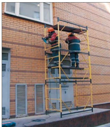
Проведение ремонтных работ на фасаде здания
