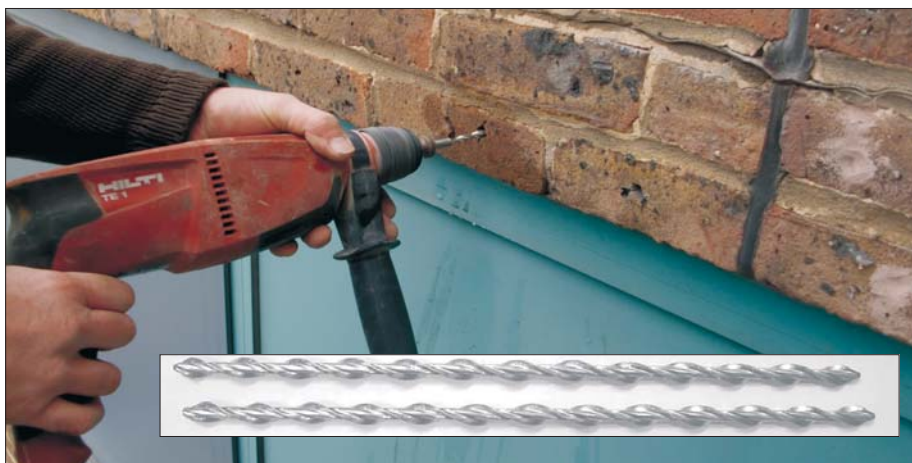
Общий вид связей и их монтажа
