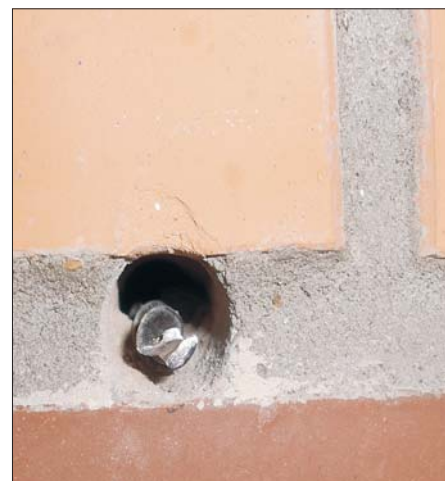
Установка ремонтных связей
