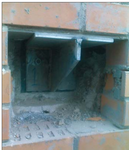
Общий вид установленного опорного металлического столика
