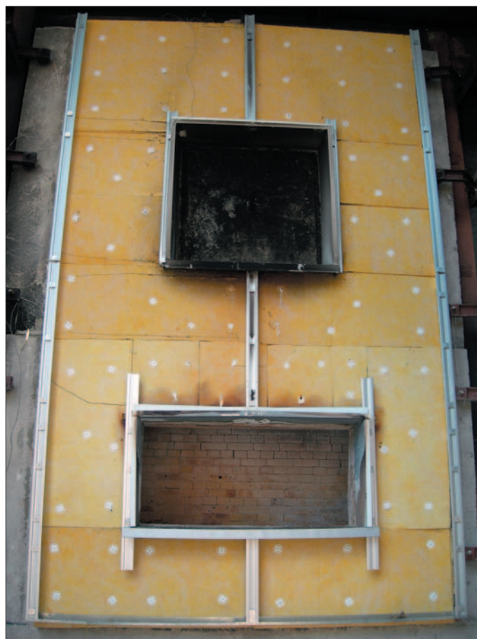
Фото 4. Общий вид после испытаний «подконструкций» образца фасадной системы «Каптехнострой» типа КТС-КХ-ХХ-ВХ (КТС-4)
