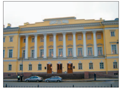
Фото 2. Здания Сената и Синода, Санкт-Петербург (гидроизоляция weber, Deitermann)
