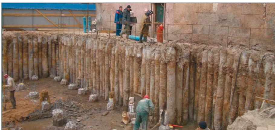
Фото 1. Пример устройства ограждений методом «стена в грунте» касательных и секущихся буронабивных свай в Санкт-Петербурге фирмой ЗАО «Геострой»
