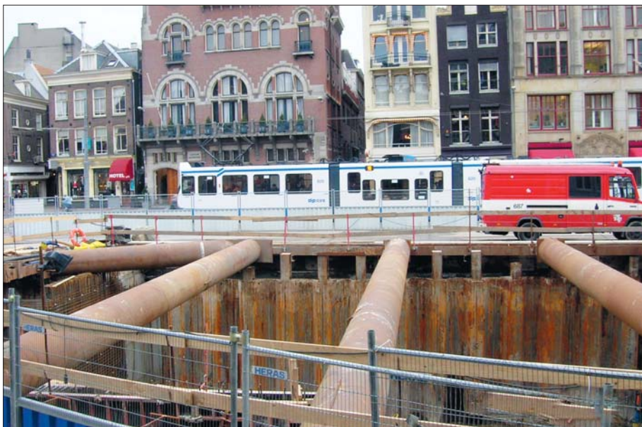
Фото 5. Устройство метро в центре Амстердама открытым способом
