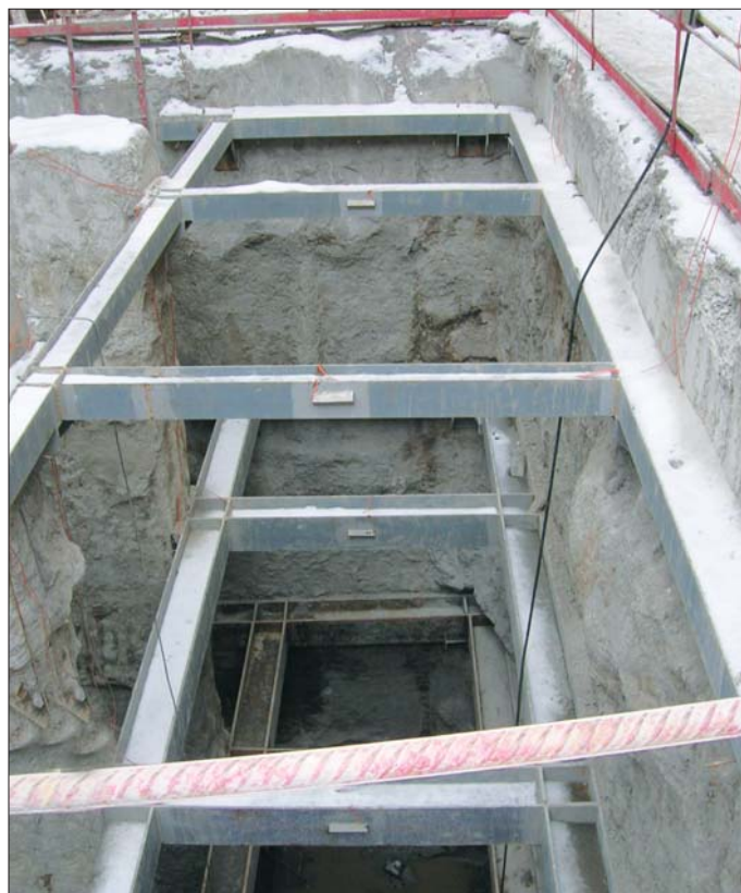
Фото 3. Устройство опытного котлована выполнено методом «стена в грунте» фирмой ЗАО «Геозол»
