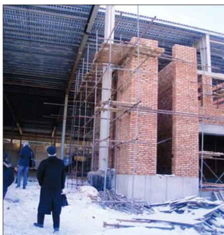
Фото 2. Строительство большепролетного складского комплекса «Лого-Арт» в Шереметьево (срок проведения строительства: февраль – декабрь 2007 г.)
