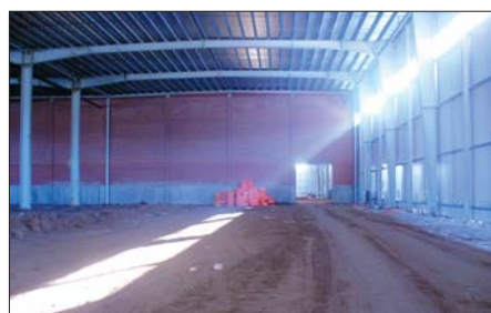
Фото 3. «Лого-Арт» внутри: сочетание «легких» и «тяжелых» металлических конструкций в большепролетном здании (общий вид складского помещения)
