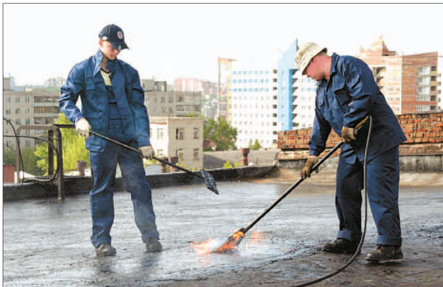
Выполнение капитального ремонта мягкой кровли по ВИР-технологии
