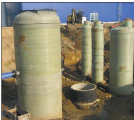
Канализационная насосная станция (устройство колодца)
