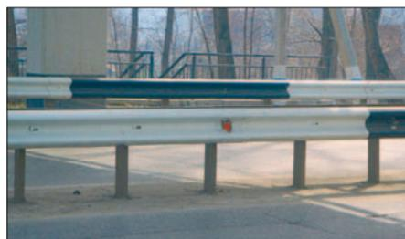
Задача этих ограждений вполне понятна — предотвращение съезда автомобилей по ходу движения, предотвращение встречных столкновений и разделение транспортных потоков как в городской черте, так и вне города. Одним из основных критериев считается удержание автомобиля на проезжей части.
