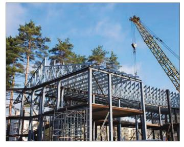
рину пролета до 30 м и производить установку грузоподъемных механизмов без применения черного металла и сварочных работ, повышая тем самым надежность конструкции.
