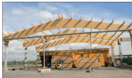
Крытый склад для сушки пиломатериалов в СПб (Колпино). Используются гнуто-клееные балки типа «бумеранг», пролет — 27 м
