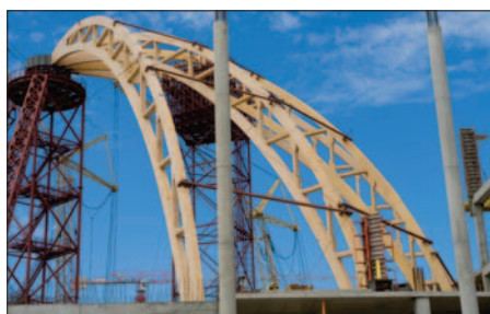
Парк 300-летия СПб. Деревянные конструкции — меридиональные ребра с хордой 60 м — для купольной части здания аквапарка диаметром 90 м
