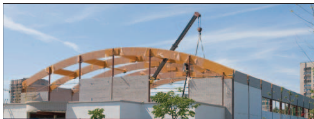
Многофункциональный спортивный комплекс с игровыми залами в Калининском районе СПб, арки пролетом 36 м
