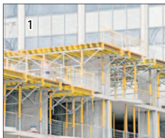
Чтобы смонтировать 150 кв. м (24,4х6,1 м) опалубки перекрытий за 3 минуты, помимо столов SKYTABLE (1) необходимо иметь траверсу с регулируемой длиной строп (2) и направляющим устройством (3), ограничитель (4), связи (5) и подкатные колеса (6).
