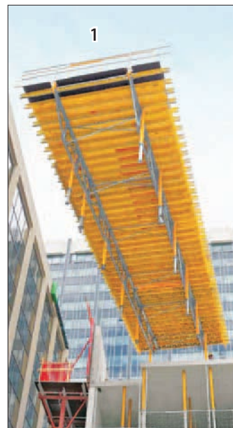
Чтобы смонтировать 150 кв. м (24,4х6,1 м) опалубки перекрытий за 3 минуты, помимо столов SKYTABLE (1) необходимо иметь траверсу с регулируемой длиной строп (2) и направляющим устройством (3), ограничитель (4), связи (5) и подкатные колеса (6).
