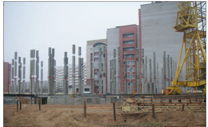
Фото 3. Начало строительства — май 2007 г.
