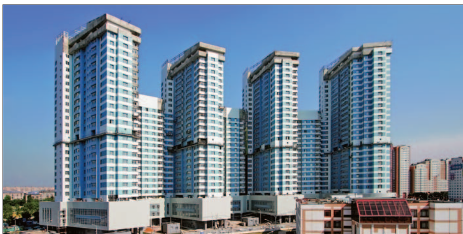
Жилой комплекс «АВИАПАРК» на Ходынке. Система утепления ISOVER ВентФасад
