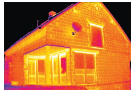
Термограмма частного жилого дома позволяет моментально снять тепловой профиль объекта
