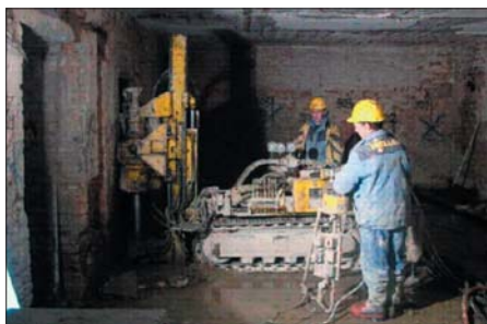
Фото 1. Работа в подвальном помещении по усилению фундамента методом струйной технологии
