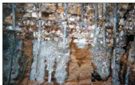
Фото 2. Закрепление основания методом струйной технологии под бутовым фундаментом здания постройки середины XIX в. (Васильевский остров)
