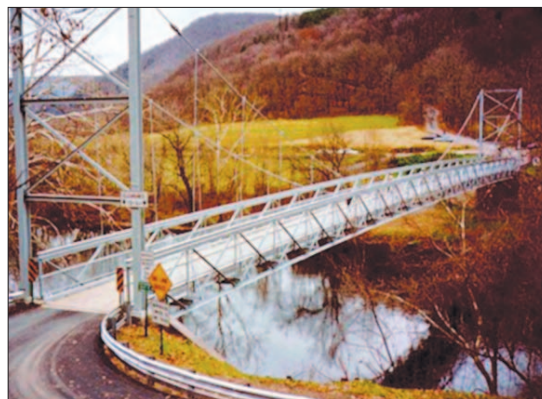
Рис. 1 Реконструированный исторический мост в Пенсильвании (США)
