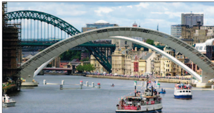
Рис. 2. Gateshead Millennium Bridge, повернутый на 45°, пропускает корабли
