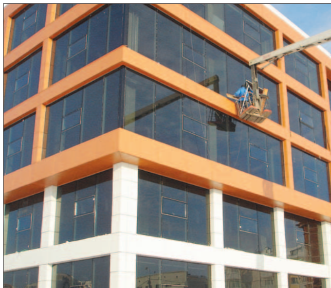
Административное здание (г. Уфа). Применена п-образная подсистема навесного вентилируемого фасада
