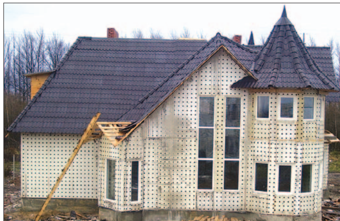
Строящийся коттедж (г. Тула)
