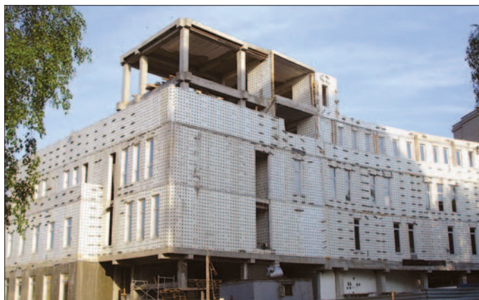
Строительство торгового центра (г. Нижний Новгород)
