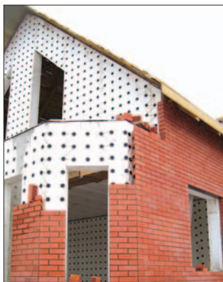
Наружная отделка (облицовка кирпичом)
