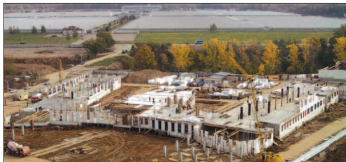
Строительство общеобразовательной школы (г. Московский)
