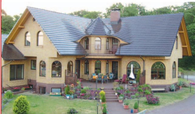
Арочные перемычки
