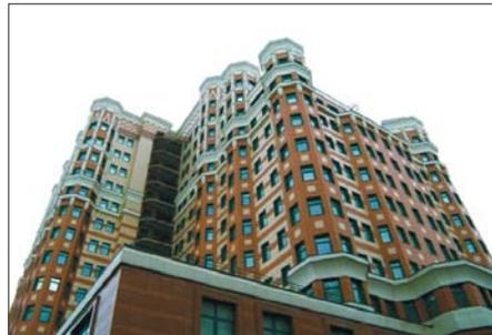
Фото 2. Здание с вентилируемым фасадом (ул. Житная, Москва, МВД России), защитный экран — из керамогранита
