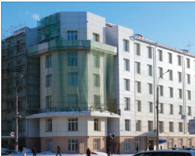
Реконструкция здания управления ЗСЖД (г. Новосибирск, пр-т Димитрова, 8)
