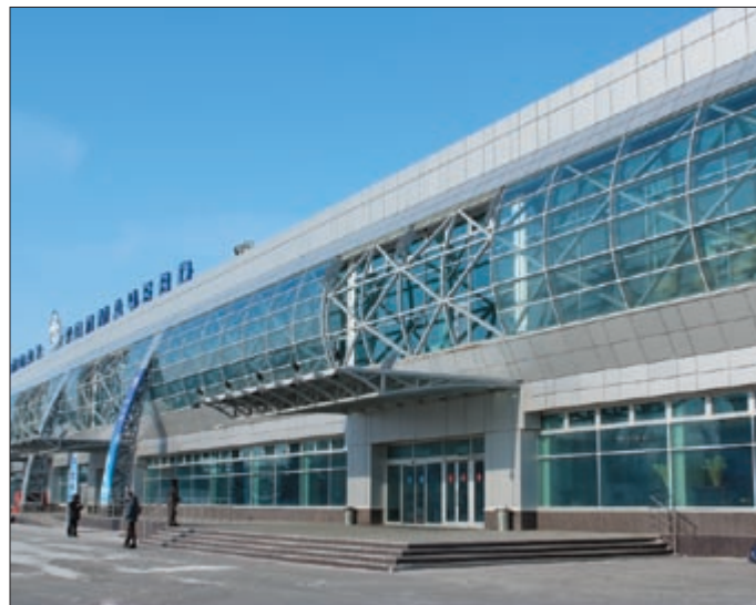
Пассажирский терминал аэропорта «Толмачево» (г. Новосибирск)
