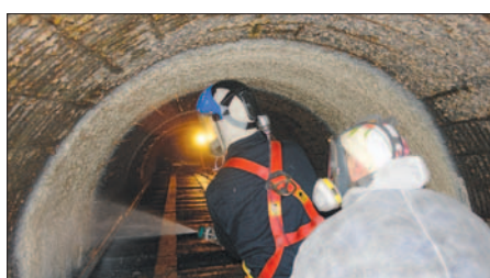
Реконструкция канализационного коллектора (г. Набережные Челны)
