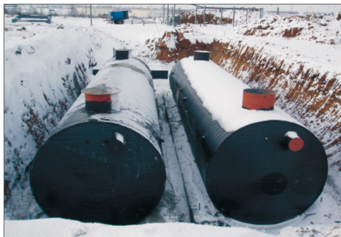
Защита от коррозии подземных стальных емкостей объемом до 100 м 3 (ООО «Роснефтекомплект», январь-февраль 2007 г.)
