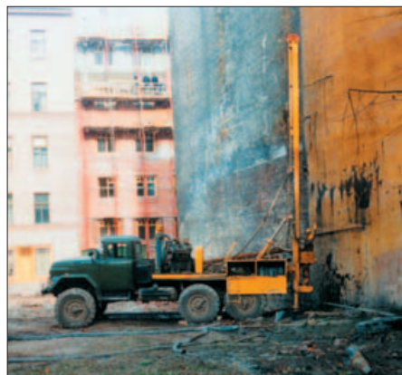
Фото 2. Выполнение буронабивных свай с использованием установки УРБ 2А2 на площадке строительства жилого дома (1993 г.)
