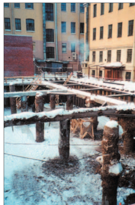
Фото 5. Использование свай, выполненных под защитой обсадной трубы, в виде колонн подземного этажа: конструктивная система — «свая-колонна» (площадка строительства на Суворовском пр., 2001 г.)
