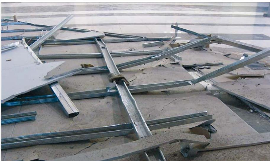
Использование некачественного профиля приводит к обрушению конструкции
