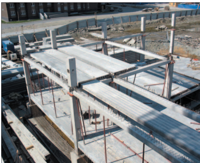
Организация максимально свободных площадей благодаря применению сборно-монолитного каркаса
