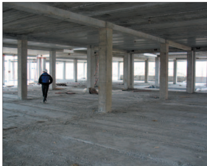
Сборно-монолитный каркас здания школы: максимальная свобода объемно-планировочных решений
