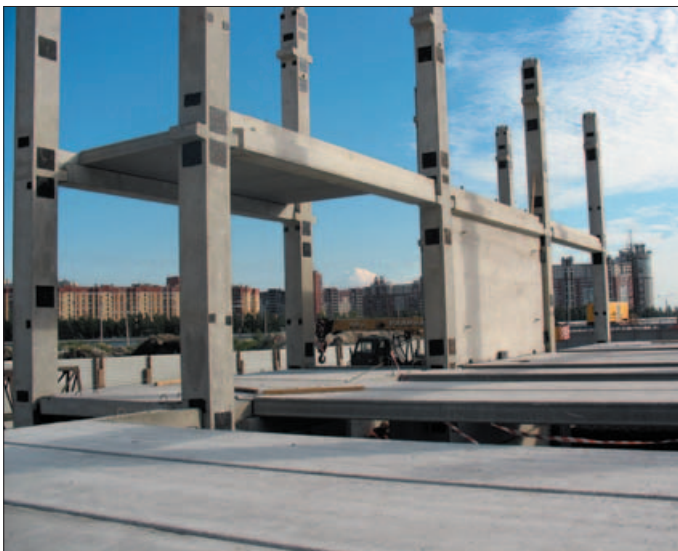
Сборный каркас здания площадью 4 500 м 2 (срок возведения — 2 месяца)
