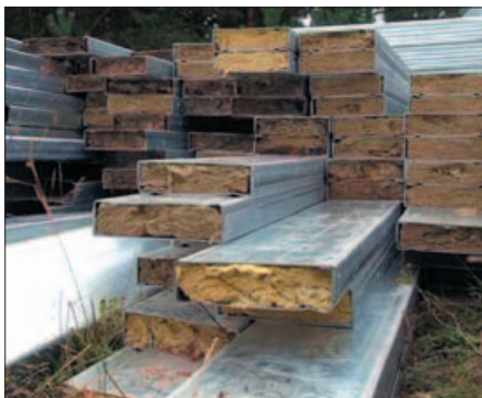
Фото 3. Коробчатые элементы каркаса, заполненного минеральной ватой
