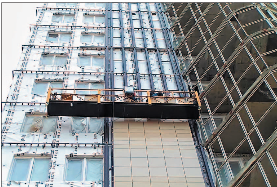
Крепление системы «РОНСОН» в межэтажные перекрытия
