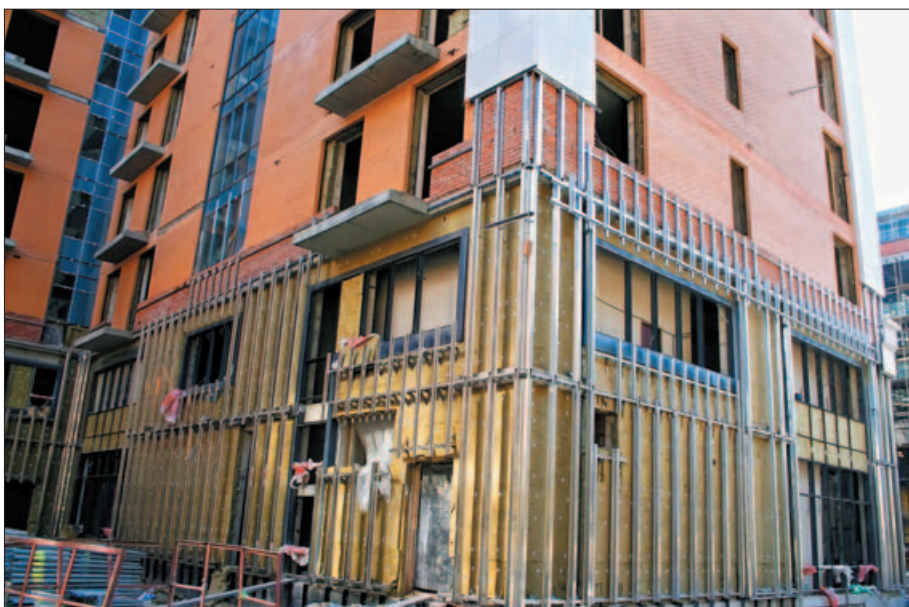
Крепление системы «РОНСОН» в межэтажные перекрытия
